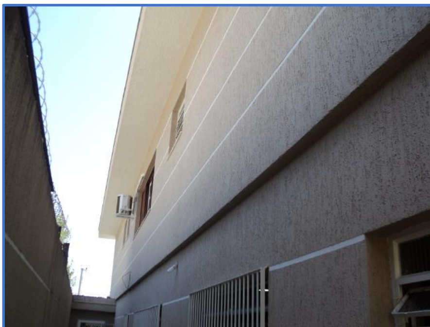
Foto: fachada lateral em bom estado.
