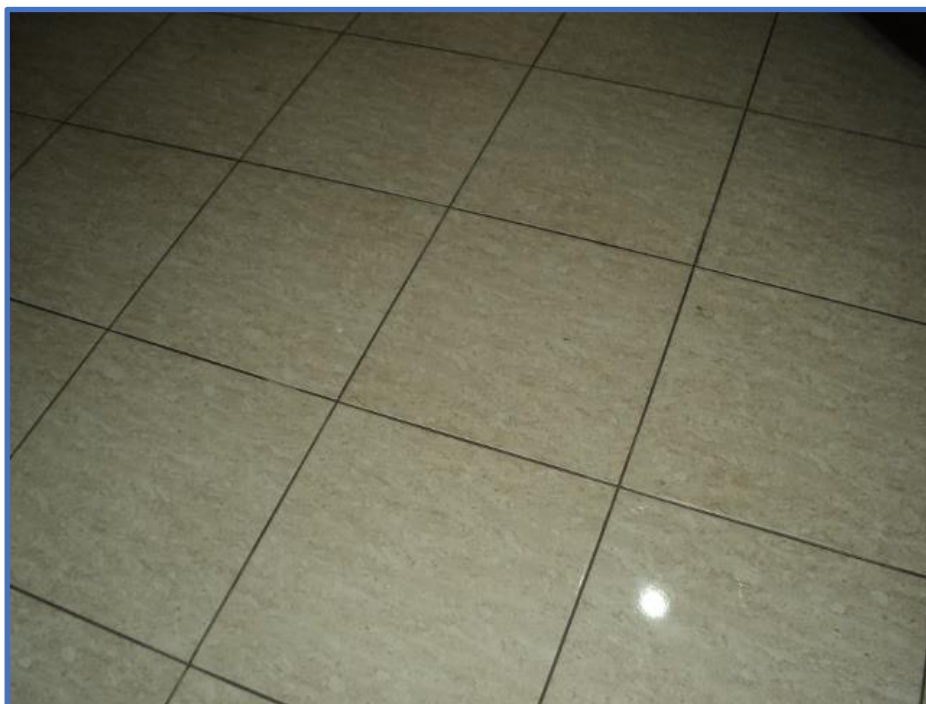
Foto: piso, em bom estado.
