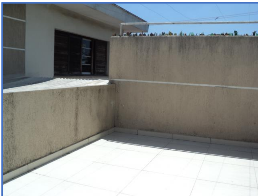
Foto: laje de edícula aos fundos.
